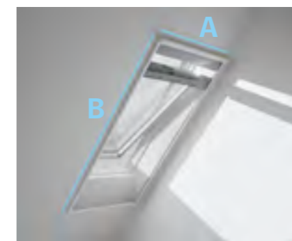
Pre výber správnej siete proti hmyzu zmerajte šírku a výšku ostenia.
